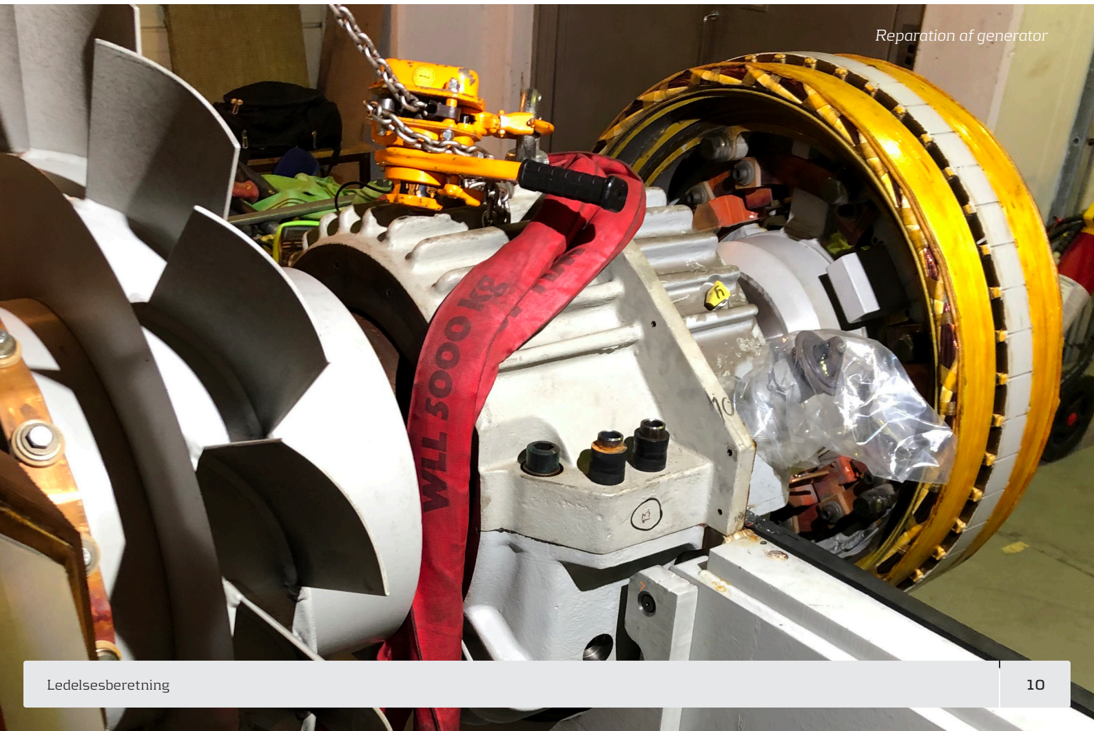
Reparation af generator
